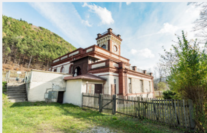
Vor 40 Jahren wurde das Kraftwerk von der EVN erworben und komplett modernisiert
