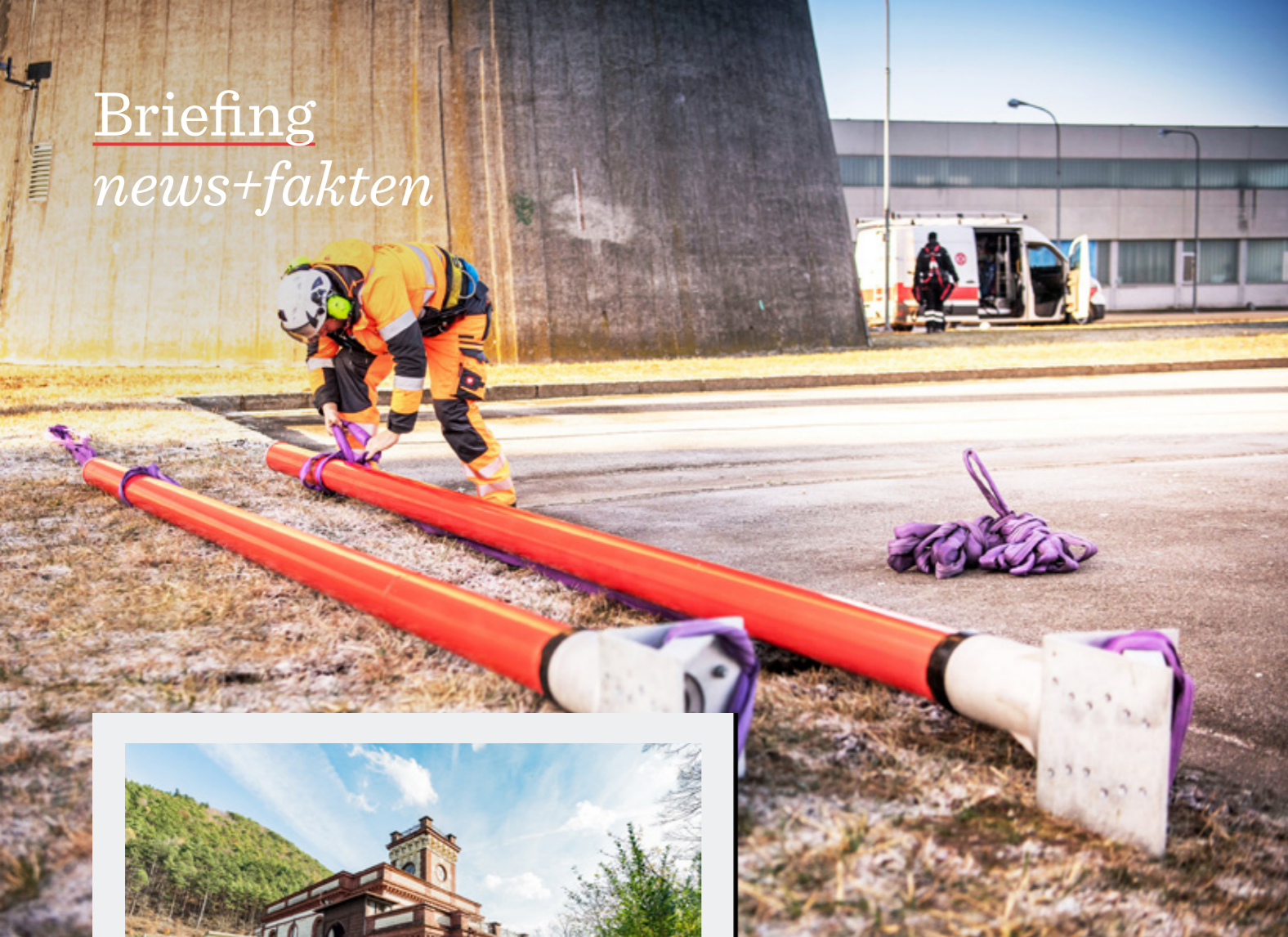
Die Antenne ist 32 kg schwer, hat einen Durchmesser von 128 mm und ist 5,5 m lang
